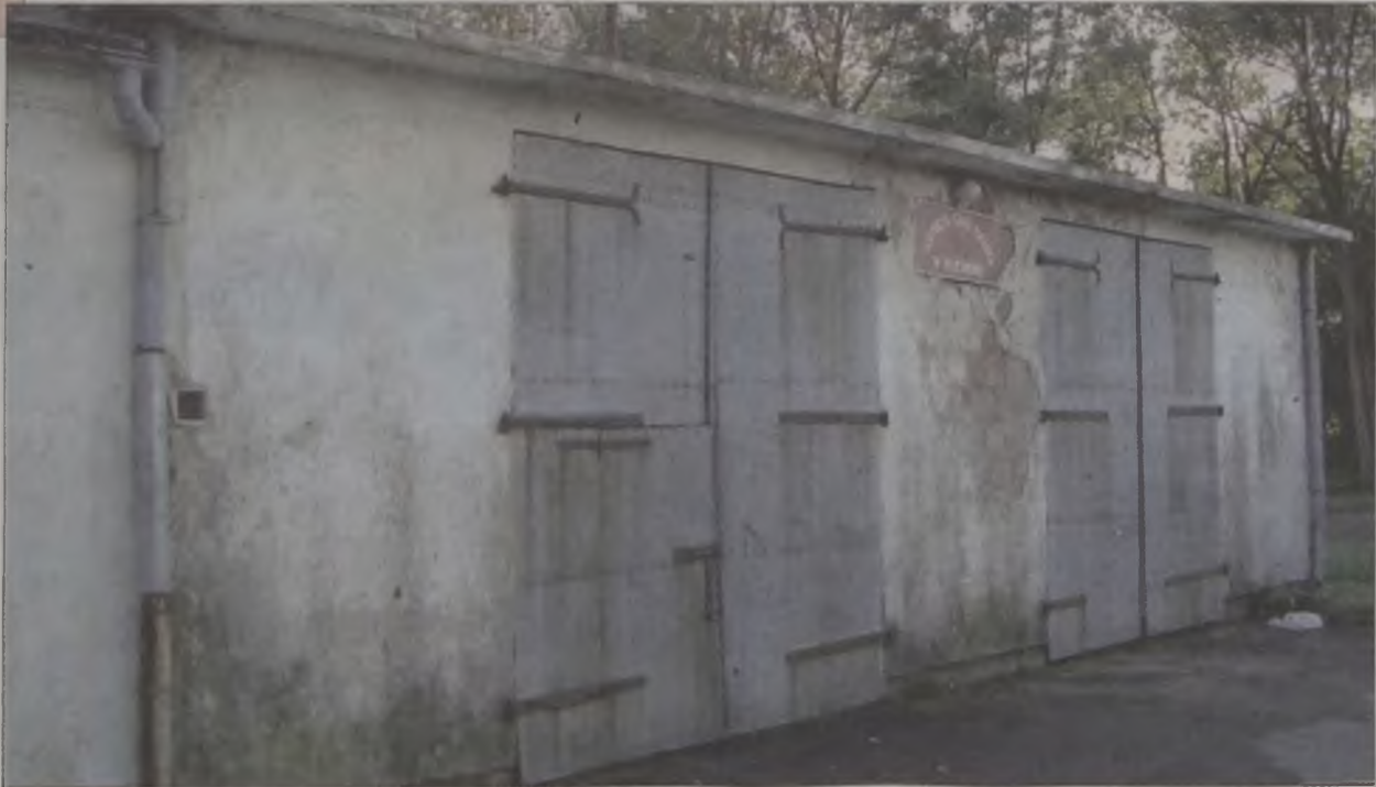
Tak wyglądała ta część remizy przed remontem.
