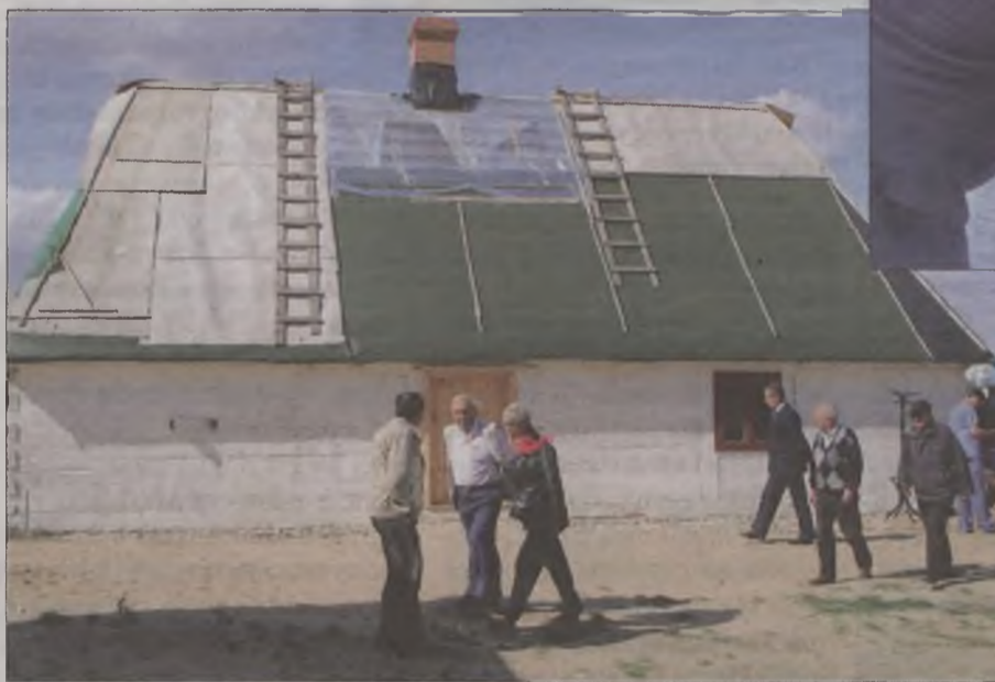
Chałupa ze Skotnik już prawie gotowa.
