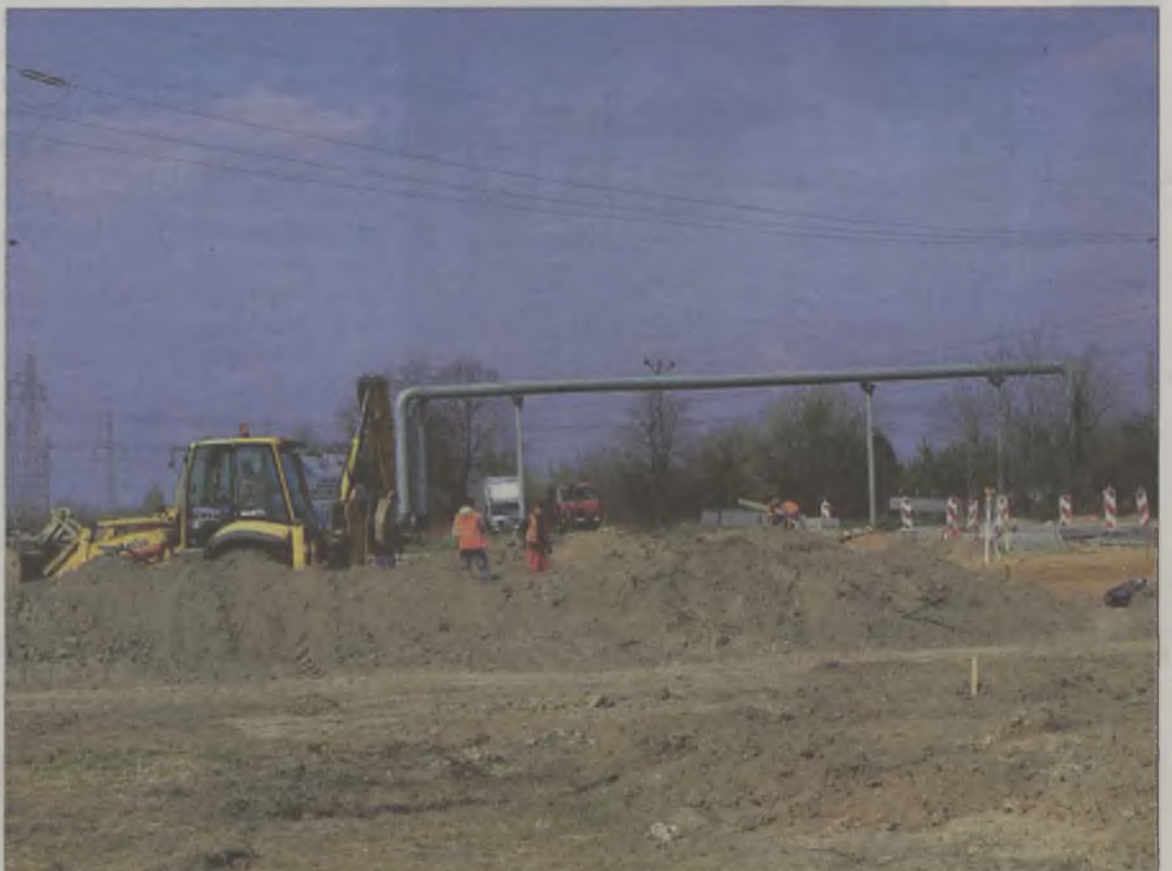
Droga, która tu powstanie będzie miała 15 metrów szerokości
