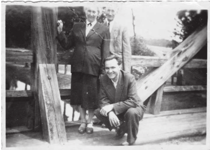
Most na kanale o który toczyły się walki
