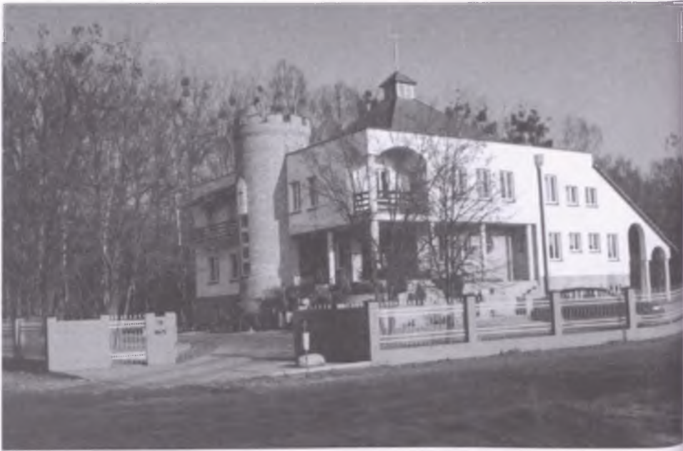
Obecny budynek kościelny Zboru przy ul. Wypoczynkowej w Nowym Tomyślu będący w użytkowaniu od roku 1993
