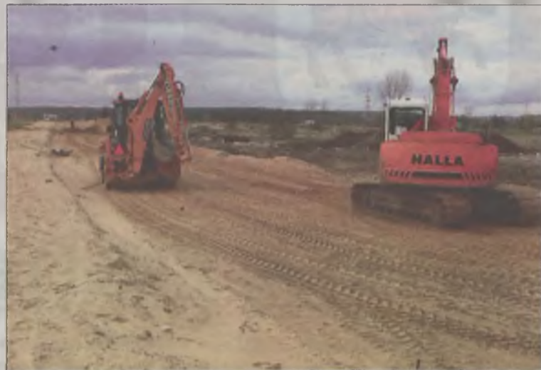
Wykonawca właśnie przystąpił do budowy ostatniego odcinka Z5 między rondem S. Mikołajczyka a Al. Jana Pawła II
