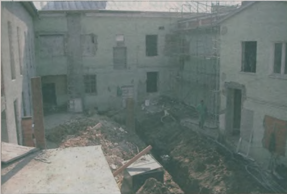
Prace nad budową dziedzińca i krużganków
