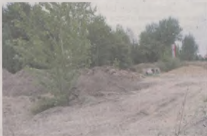
Obecnie to teren budowlany
