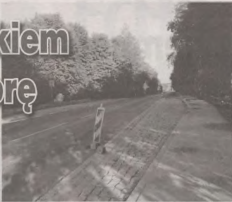
Wykonano wyłożone kostką granitową zatoki autobusowe.
