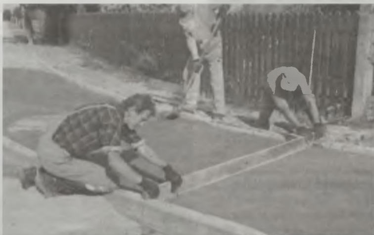
Prace przy układaniu chodnika w Kotwasicach.
