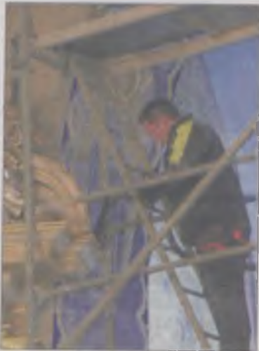
Prace nie są uciążliwe dla wiernych. Rusztowania znikną z kolegiaty przed Wielkanocą.
