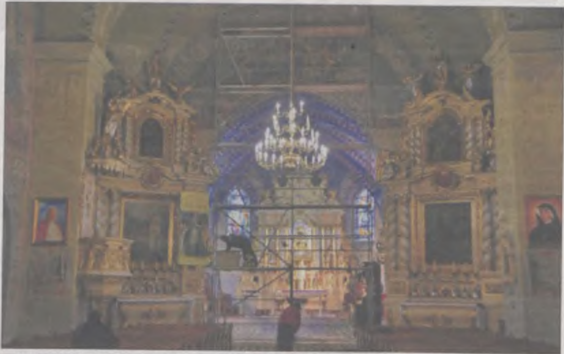
Kilkusetletnie freski są przykryte warstwami tynku i farby. Praca nad ich wydobyciem nie jest łatwa.
