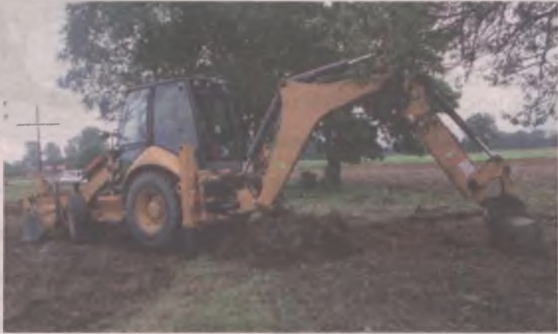
Do porządkowania cmentarza wynajęto sprzęt ze Spółdzielczego Zakładu Usługowego w Przykonie.
