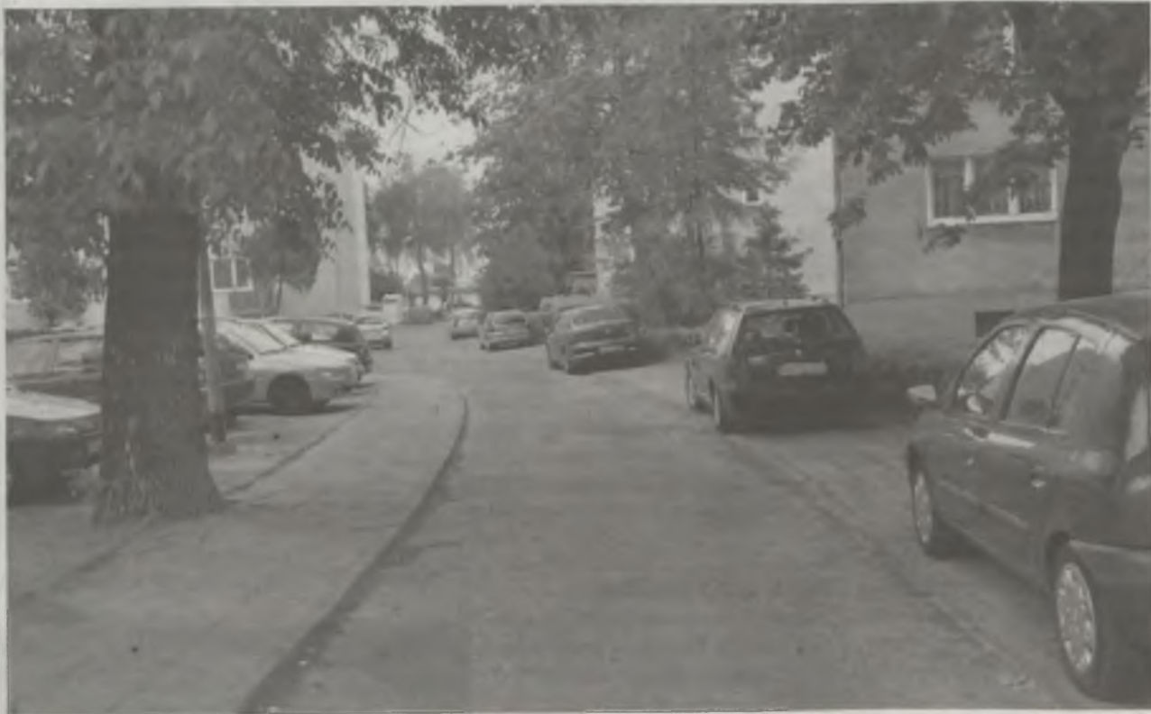
Po remoncie ulicy Stawickiego, powstanie 65 miejsc parkingowych.
