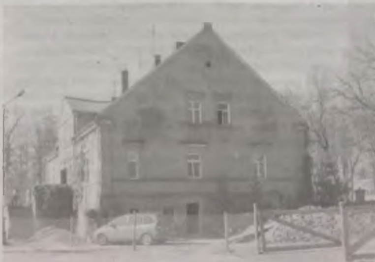
Remont rozpoczęły. Świadczą o tym zwalony gruz.
