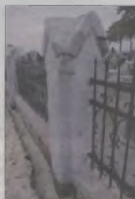
Ogrodzenie wymaga gruntownego remontu, w tym również fundamentów, które należy wzmocnić. Najbardziej zniszczone są słupki, ręcznie kute przęsła i brama są w dobrym stanie, wymagają jednak odświeżenia.
