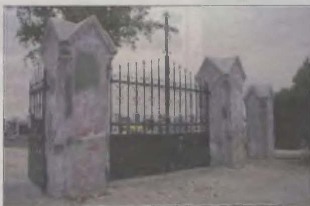
Ogrodzenie wymaga gruntownego remontu, w tym również fundamentów, które należy wzmocnić. Najbardziej zniszczone są słupki, ręcznie kute przęsła i brama są w dobrym stanie, wymagają jednak odświeżenia.
