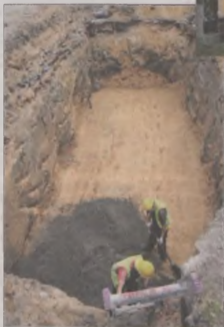
Na ukończeniu jest wykop pod zbiornik paliwowy.
