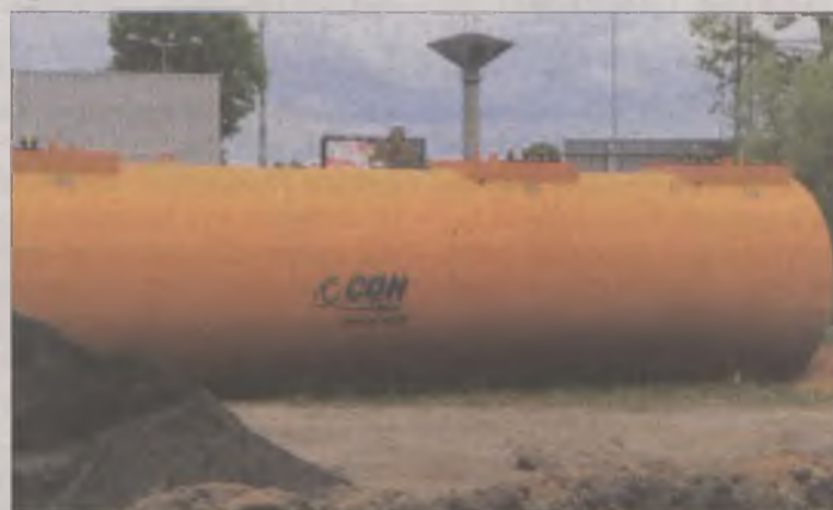
Zbiornik na trzy paliwie płynne ma objętość 60 metrów sześciennych. Oprócz tego stanie mniejszy – na 9 metrów sześciennych gazu LPG.
