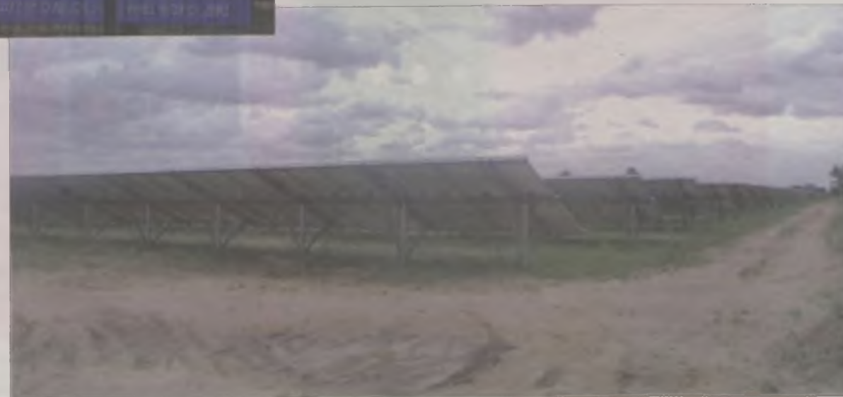
Na dwóch hektarach ustawiono blisko 4,5 tys. paneli.
