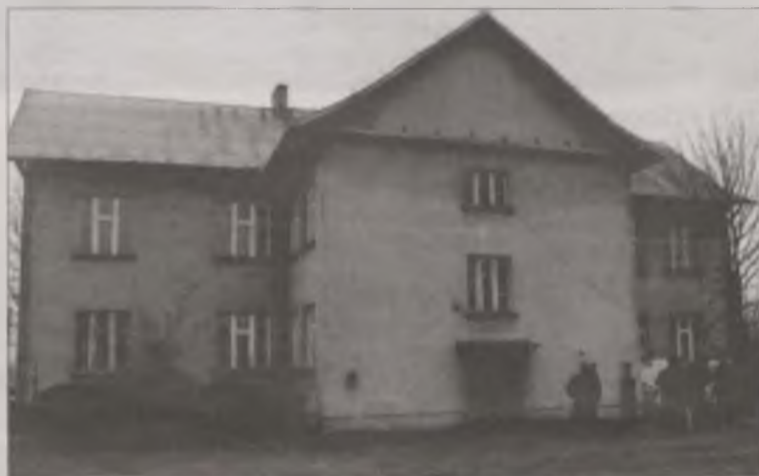
Okazały piętrowy budynek szkolny w Miłkowicach.
