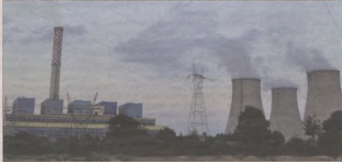
Narazie nie wiadomo kto, po zamknięciu elektrowni, będzie dostarczał ciepło dla Turku.
