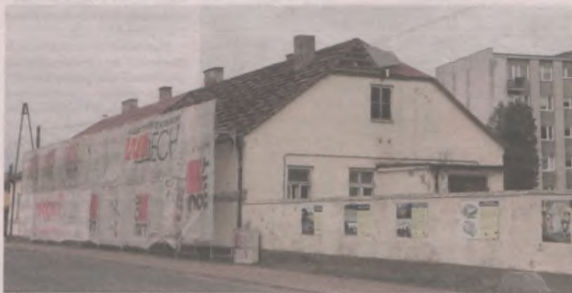
Przebudowę dawnej plebanii w Uniejowie rozpoczęła rozbiórka dachu. Nowy przykryje konstrukcję dopiero po gruntownej konserwacji tkanki historycznej, wylaniu stropu i przygotowaniu ścian poddasza.
