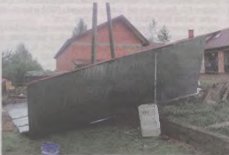
Garaż przeniosło na płot i częściowo posesję sąsiada.
