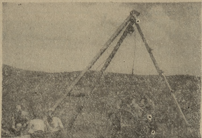
Geologowie pracują także dla hydrologów. Na zdjęciu — wiercenie badawcze w okolicach przyszłej zapory wodnej (woj. zielonogórskie)
