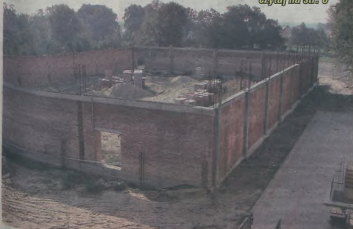
Hala przy Gimnazjum nr 2 w Turku miała być największą inwestycją czterolecia. Jednak na skutek tzw. wojny o halę, opóźnienie tej inwestycji sięga pół roku. Czy po ogłoszonym przez burmistrza Czapłę oficjalnym zakończeniu konfliktu prace przy hali nabiorą tempa?
