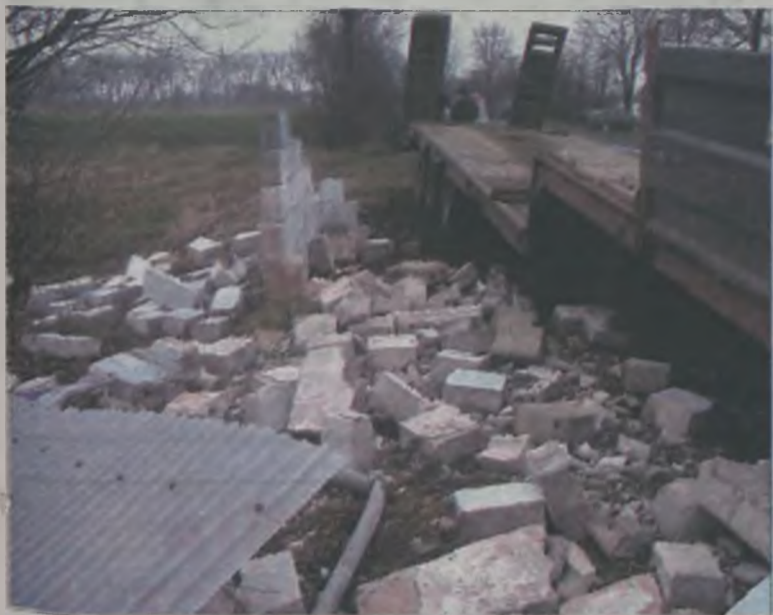
Z przystanku autobusowego w Imielkowie (gmia Tuliszków) pozostały tylko gruzy.
