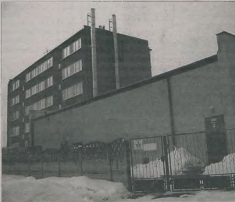
Kotłownia na Osiedlu Młodych, wybudowana w latach 2000-2002 - droga i nieekonomiczna. W efekcie budynki wspólnotowe płacą za ciepło nieprzezwyciężalnie wysokie kwoty.
