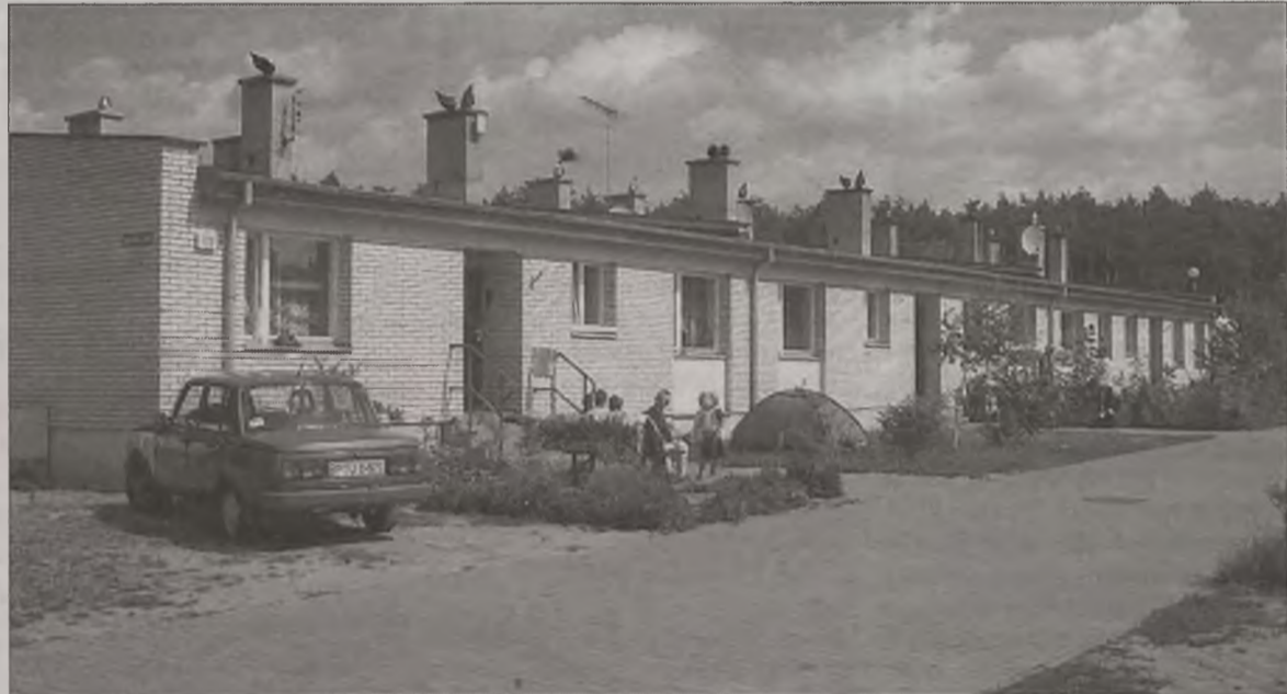
Budynek dla 11 rodzin na Zdrojkach Lewych. Zaplecze socjalne miasta.
