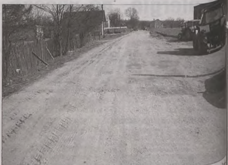
Z funduszy SAPARD wybudowana zostanie droga asfaltowa w miejscowości Czachulec Stary.
