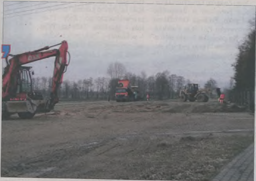
Na budowie przykościelnego parkingu.
