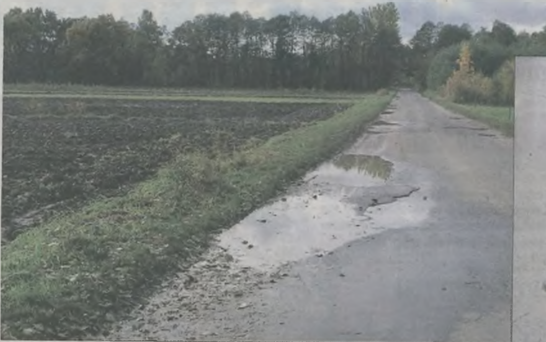
Kaluże kryją wyrwy w drodze.
