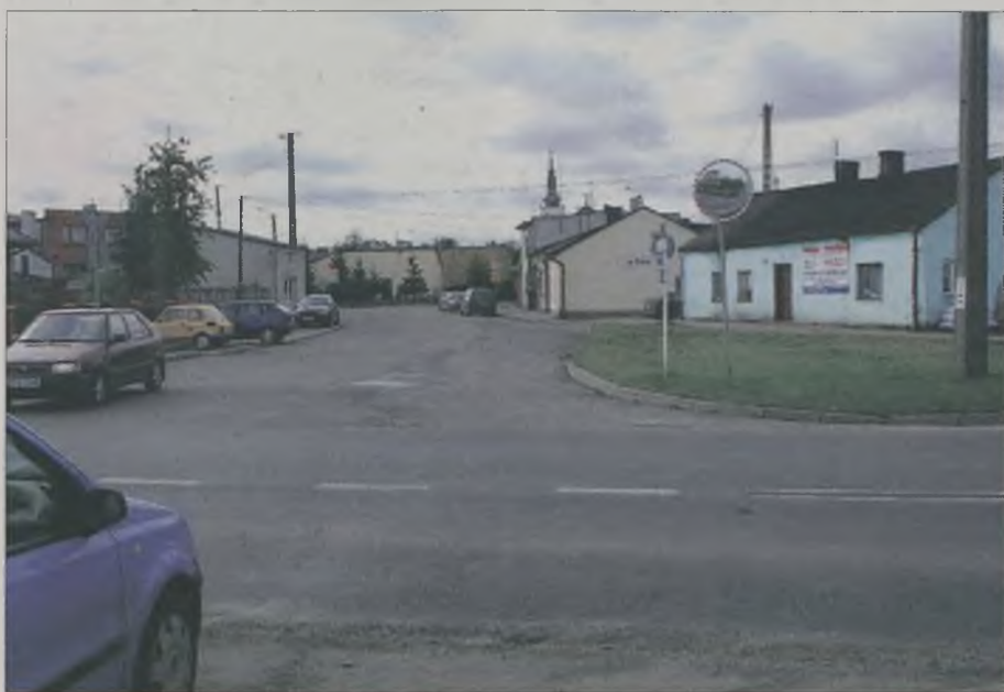
Niebezpieczne skrzyżowanie, jeszcze z lustrem.
