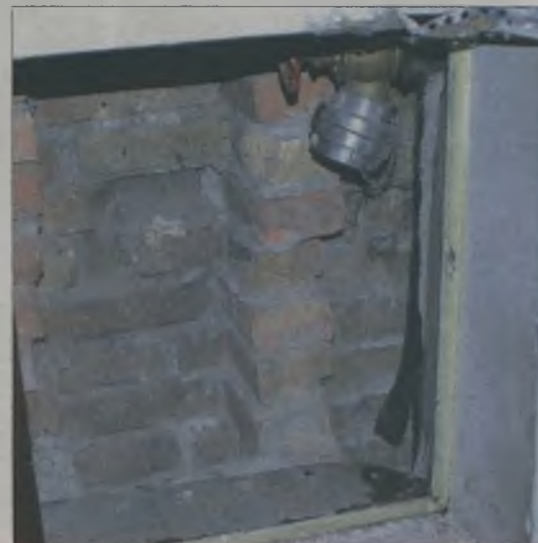
Hydrant zamontowano w kominie.
