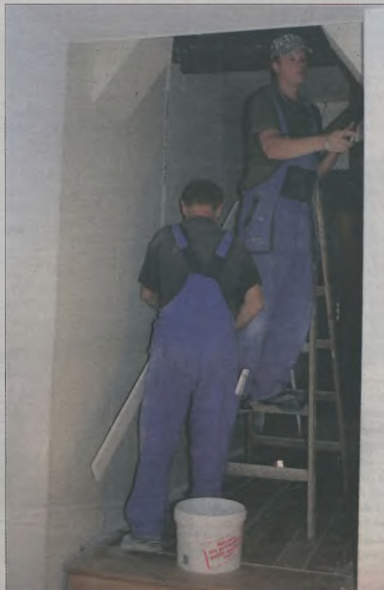
Robotnicy kończą prace remontowe.
