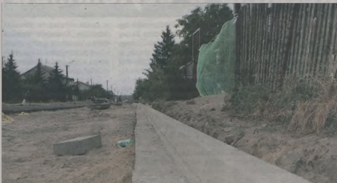
Asfalt będzie położony przy plotach, projekt nie przewiduje w tym miejscu chodników.
