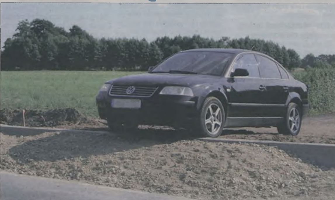
Do końca robót budowlanych turkowianin będzie miał utrudniony dojazd do własnego domu.
