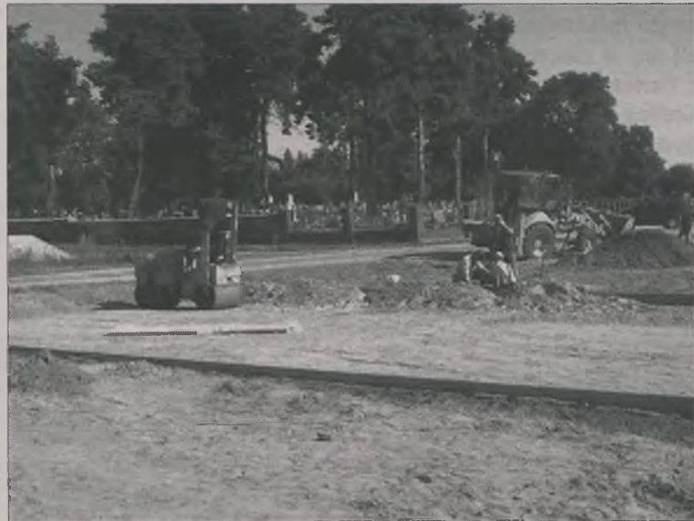
Prace na placu zabaw.
