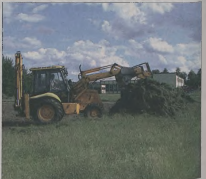
W ubiegłym tygodniu ruszyły prace budowlane obok Gimnazjum nr 1 w Turku.
