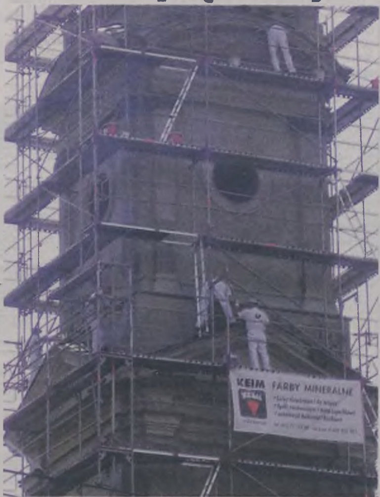
Prace na dobrskiej wieży kościelnej
