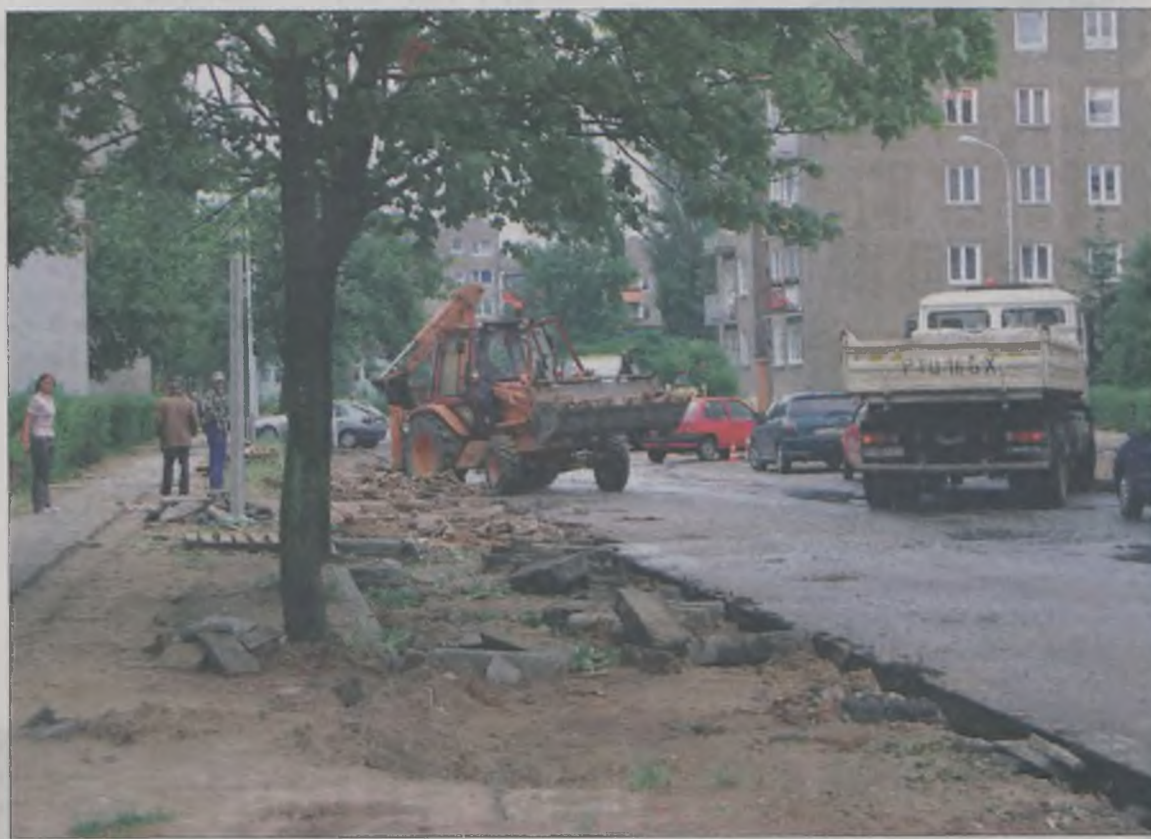
Trwająca od wiosny na P.O.W. roboty budowlane zaczynają męczyć mieszkańców.
