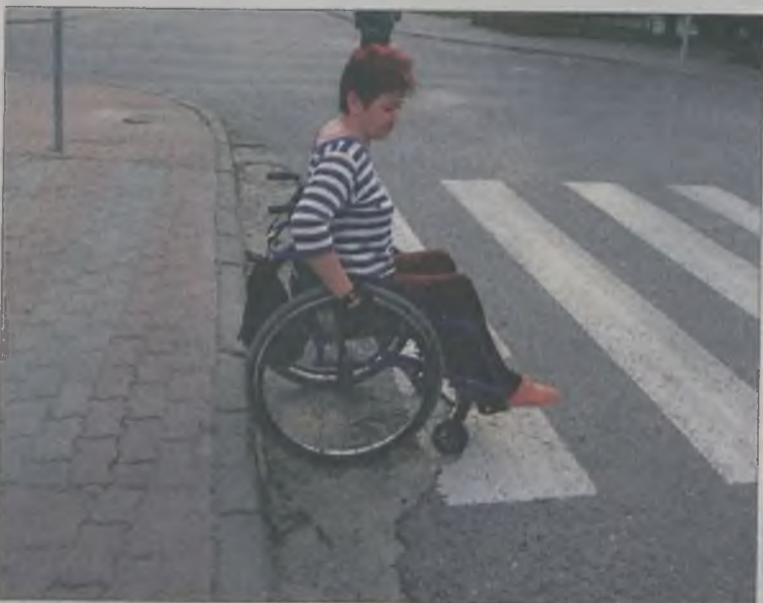
Przy jednym z przejść wózek wpada w szeroki pas dziurawej jezdni. Trudno się z niego wydostać.
