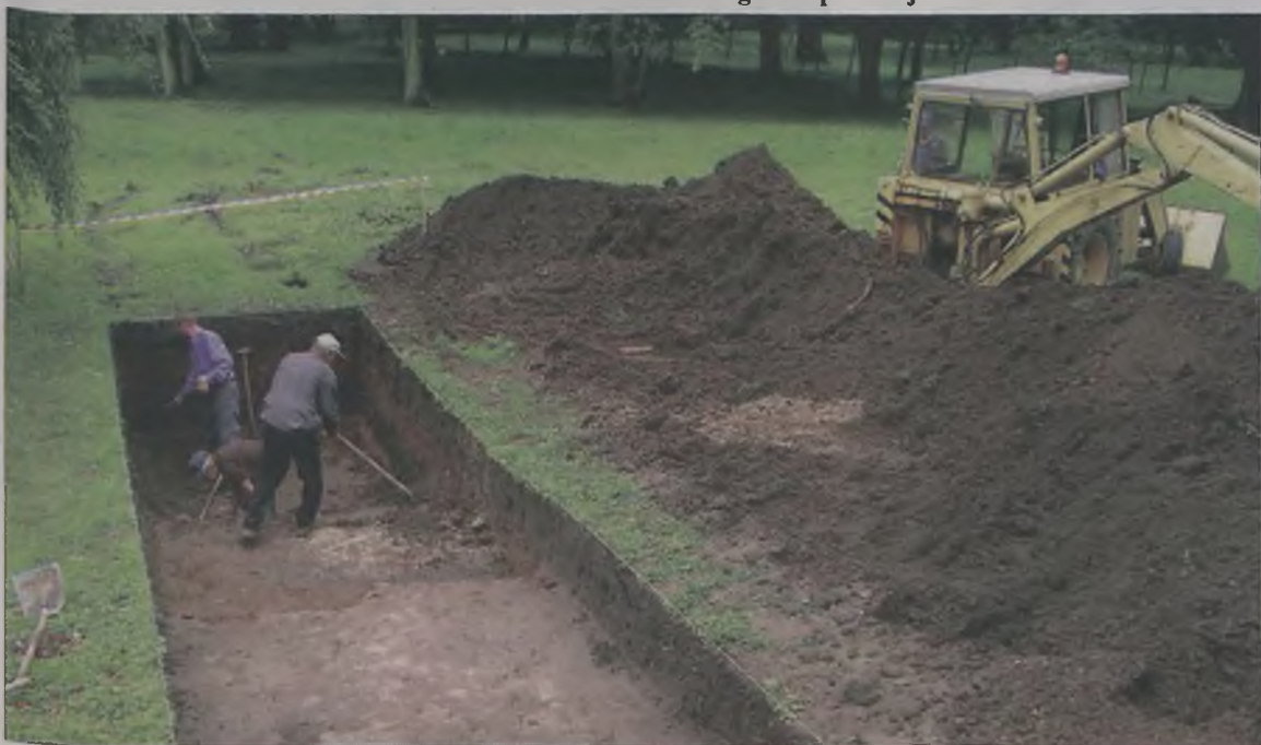
Roboty ziemne wykonują miejscowi pracownicy.
