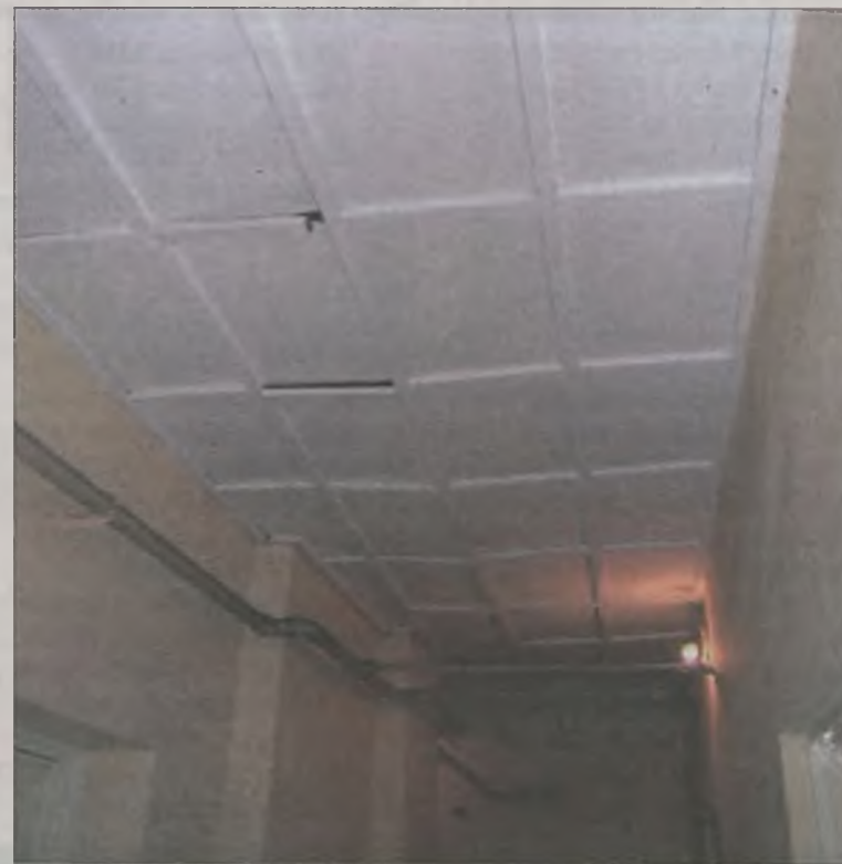
Sufit i ściany budynku przy Polnej są zrobione z płyt pilśniowych.
