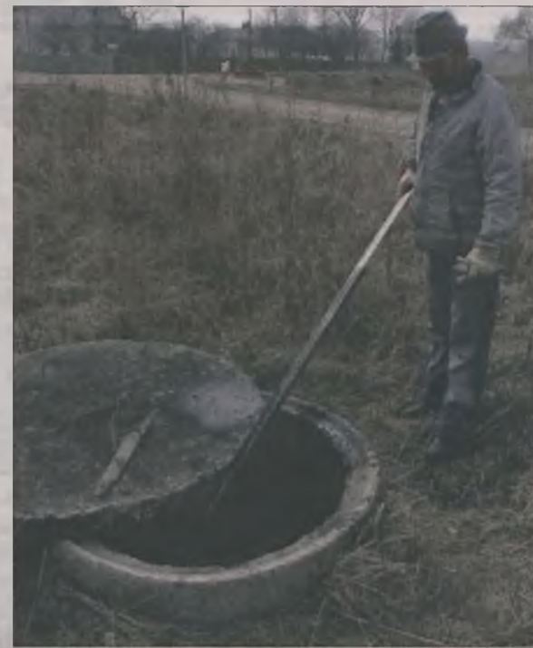
W studzience melioracyjnej znajduje się około 200 litrów czarnej substancji ropopochodnej.
