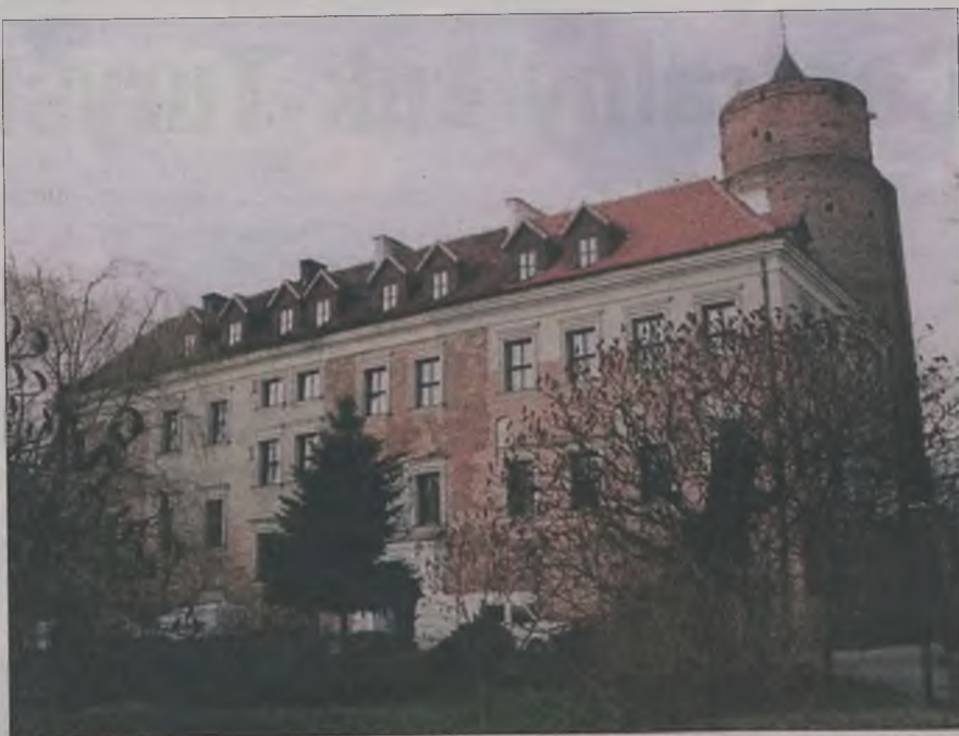
Zamek czeka na remont.
