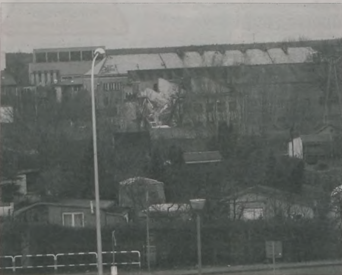
Rozbiórka budynku tzw. starej „Mirandy” trwa już od miesiąca.
