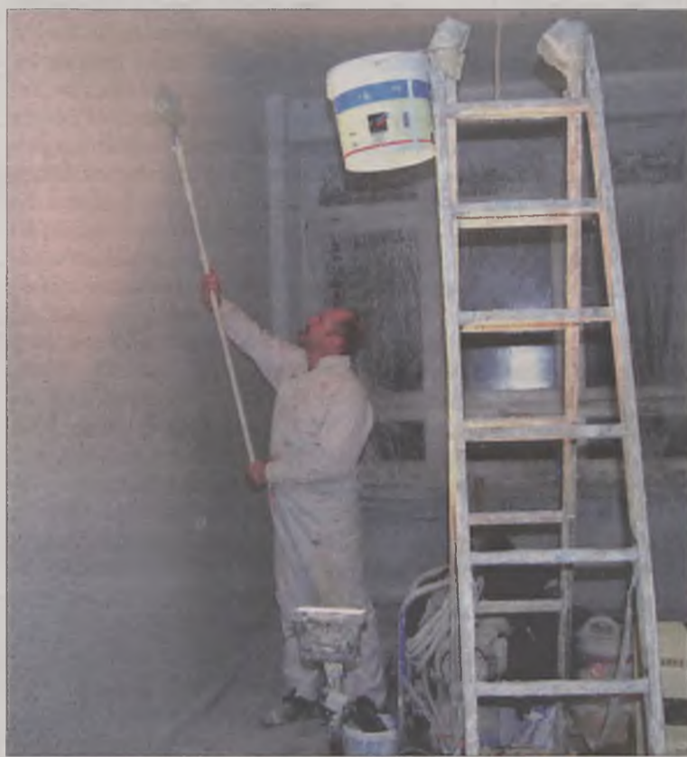
Jacek Sulkowski zajął się remontowaniem świetlicy.
