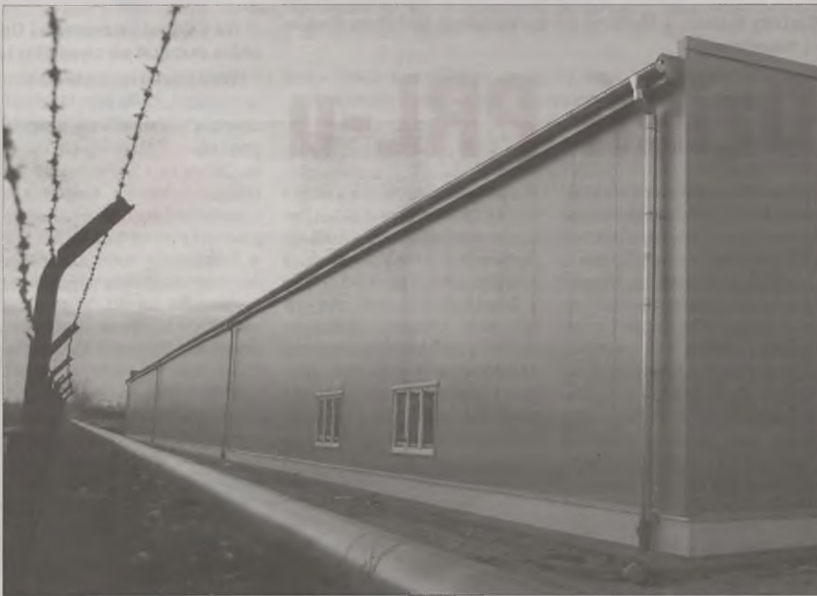
W kwietniu przyszłego roku w tym obiekcie rozpocznie funkcjonowanie nowoczesna, kosztująca 9 mln zł, galwanizernia, która w połowie zostanie sfinansowana ze środków unijnych. Pieniądze te spółka Sintur pozyskała w ramach programu „Innowacyjna gospodarka”.
