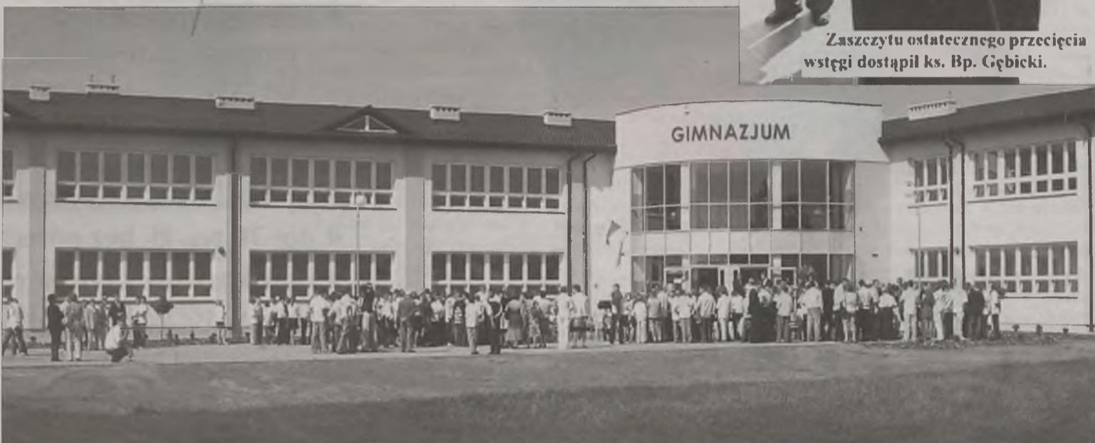
Architektura budynku gimnazjum przyciąga wzrok.
