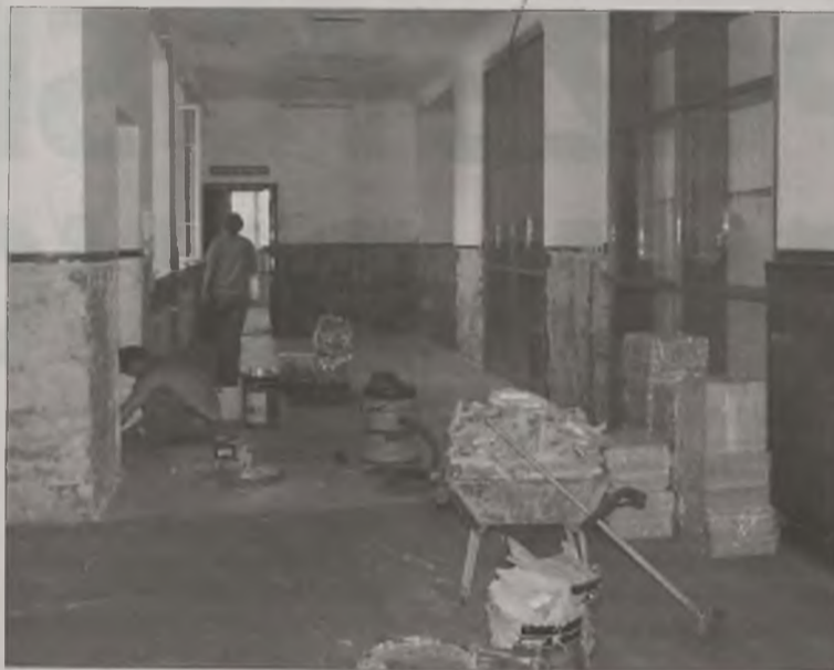
Zastąpienie posadzki pakietem oraz położenie boazerii na szkolnych korytarzach, na pewno zmienią wygląd parterowej części budynku.
