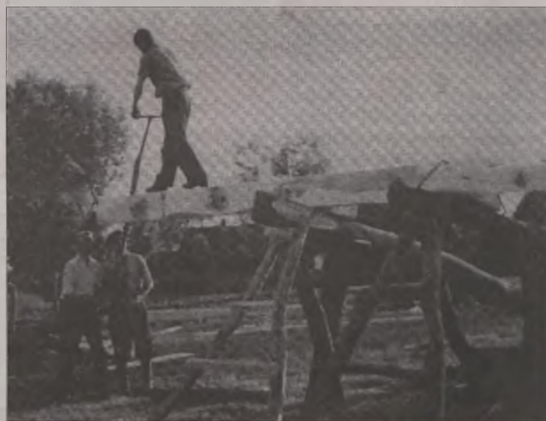
Przecieranie wzdłużne drewna na kobyłkach.
