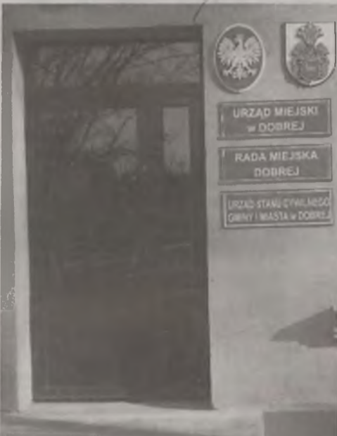
Nowe wejście do Urzędu Miejskiego w Dobrej.
