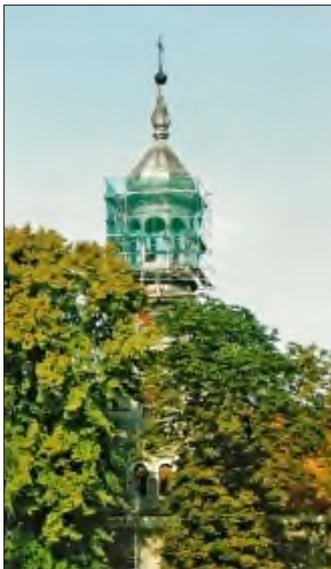
Gruntowny remont wieży kościelnej – położenie blachy miedzianej. Lato 2009 r.
