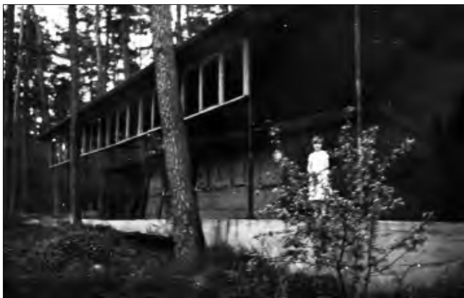
Pierwszy hangar w Gołuchowie (betlejemka). Widoczne fundamenty i elementy konstrukcji obecnego hangaru.
