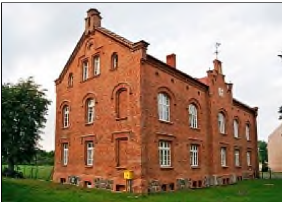
Dom po remoncie, rok 2014
