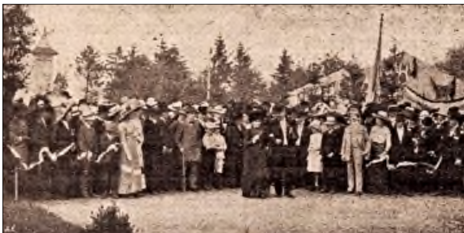
„Pani Gdeczykowa przecięła wstęgę błękitną odznaczającą plac budynków wystawowych”
