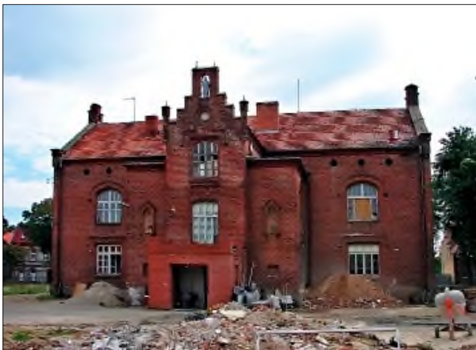
Dom Sióstr Salezjanek przed rozpoczęciem remontu
