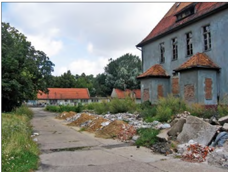
Budynek dawnego szpitalika wojskowego, na miejscu którego powstał kompleks sportowy
