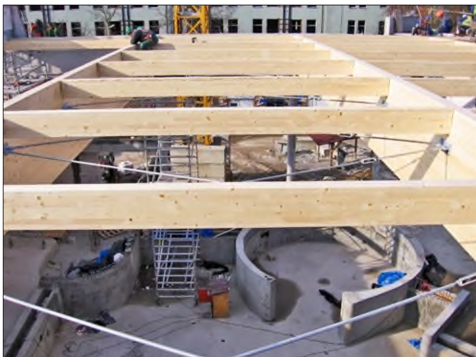
Kompleks sportowy w trakcie budowy
