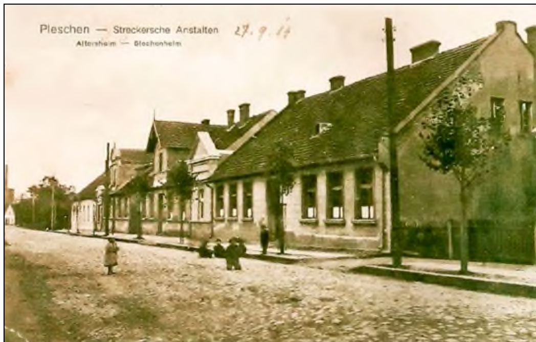
Widokówka przedstawiająca zakłady Streckera przy ul. Podgórznej, wyd. A. Schaefer, Pleszew, przed 1914 (ze zbiorów M. Marciniaka).
