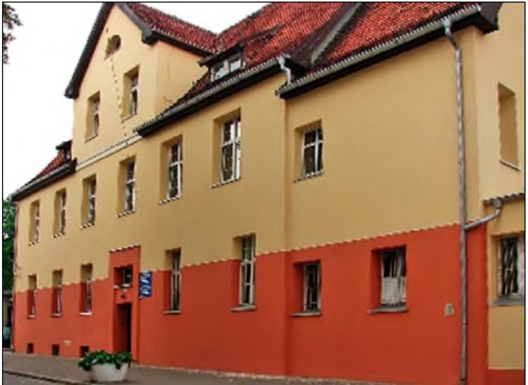
Budynek administracyjny po termomodernizacji.
